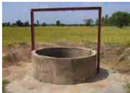
上：コンクリート製の水門。* 左：ほ場の各所に見られる、雨水を貯める地下2mほどの貯水槽（ティンティロウ地区）。*
