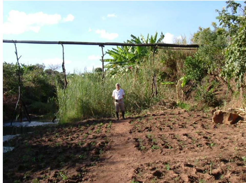
トタンを利用して作成した 水路橋(約40m)
