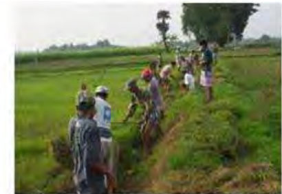
農民水利組織による水路の整備 (受益者の共同作業による管理)
