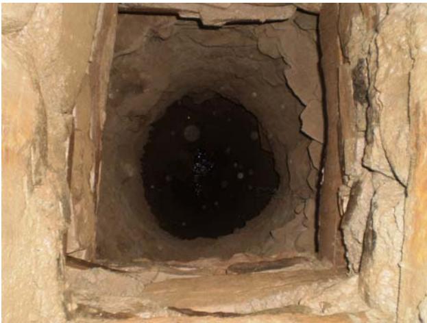
カレズ立坑の内部
