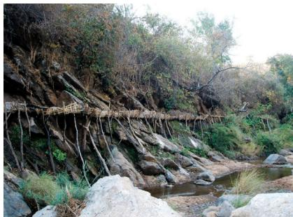
写真6 竹や現地で入手できる材料を用いて作られた水路（JICAが支援する小規模灌漑プロジェクトサイト）
